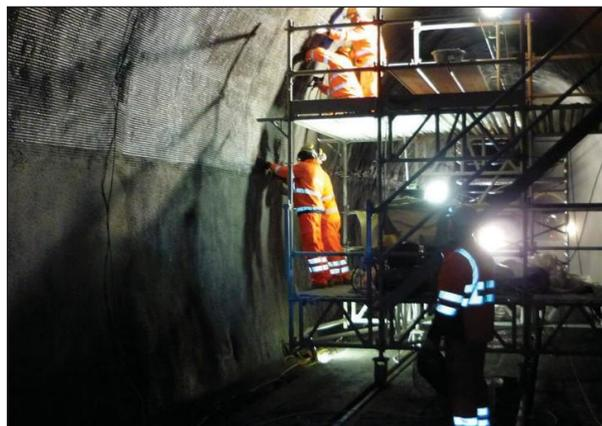
Dependendo do processo de aplicação da argamassa, a malha de reforço S&P ARMO--mesh® será embebida na argamassa, ou fixada na primeira camada de argamassa projetada através de elementos de fixação ou grampos de inox. Em ambos os casos, a malha de reforço deve ser recoberta de acordo com os requisitos e regulamentos específicos – ver especificações nas instruções de aplicação das argamassas respectivas.
